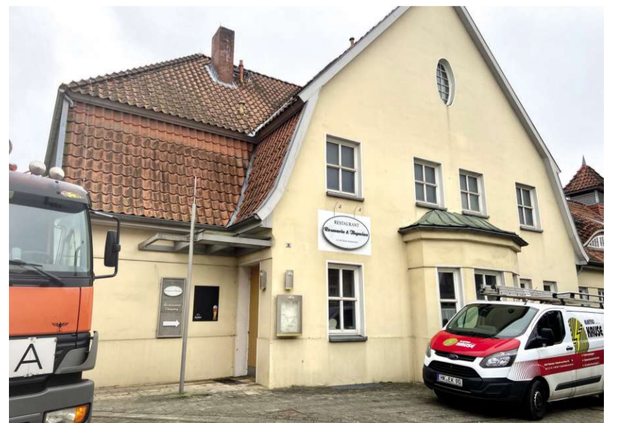
Handwerker im Einsatz: In den kommenden Wochen wird der Pulverkrug für den Großküchenbetrieb ertüchtigt. Im vorderen Bereich wird das Restaurant wiederbelebt.
